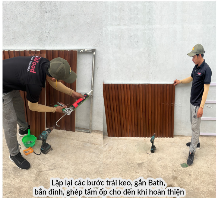
Tiếp tục gắn Bath inox, bồn đĩnh cho tấm ốp
