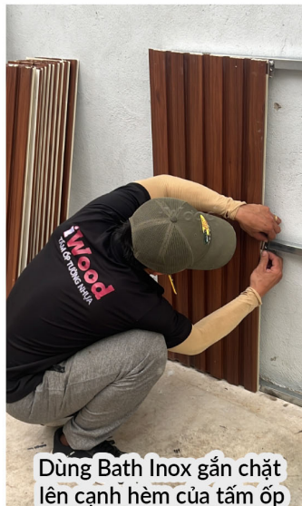
Dùng súng bắn đinh, bắn trực tiếp vào Bath inox lên khung sắt
