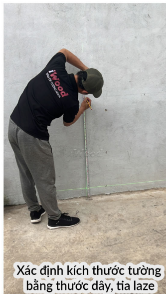
Chia tấm ốp sau cho phù hợp với mặt bằng cần thi công
