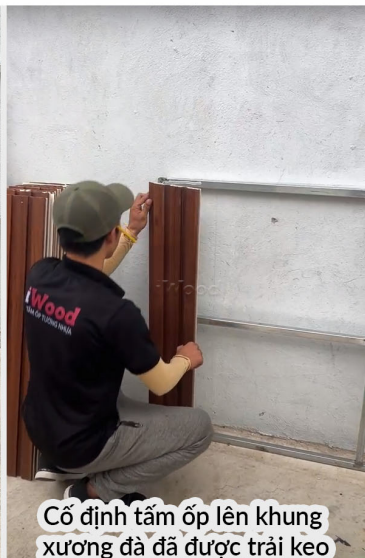
Dùng Bath Inox gắn chặt lên cạnh hèm của tấm ốp
